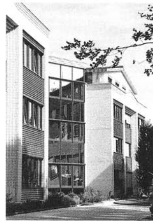
Das High-Tech-Center HTC2 Thurgau-Tägerwilen soll nächstes Jahr voll ausgelastet sein.
